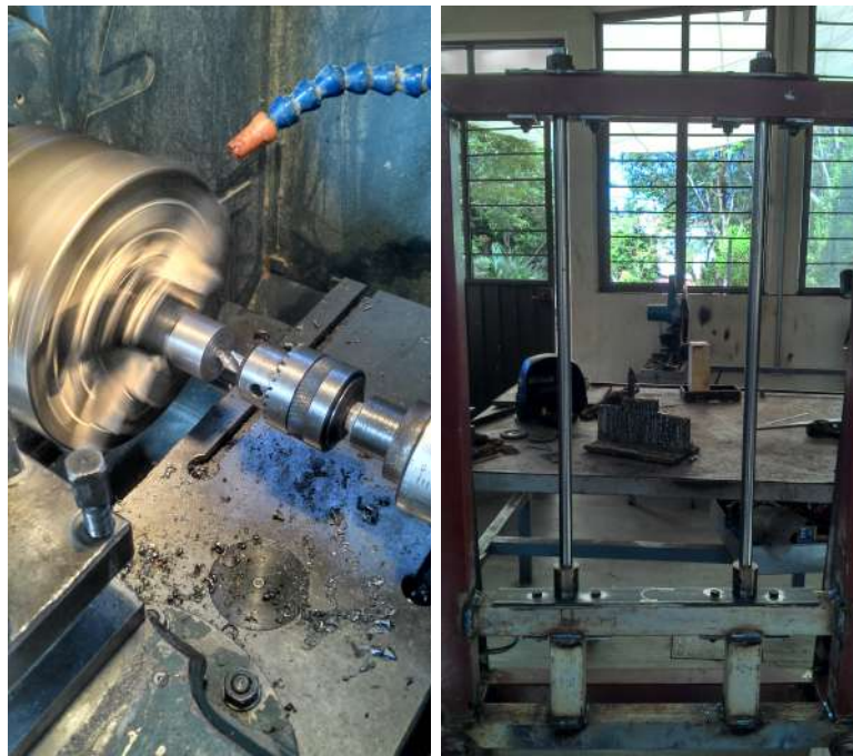
Figura 3.28: Acoplamiento del sistema de guiado a la estructura de soporte: desbaste interior de los bujes para la sujeción de las guías (izquierda) y montaje del sistema de guiado (derecha).
