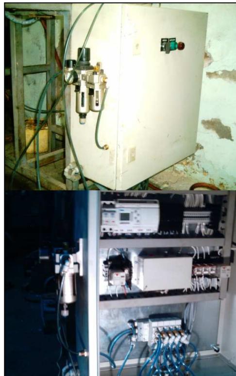
Fig. 10. Instalación de gabinete de control con sus accesorios.
