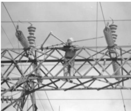
Fig. 1. Operador limpiando aisladores eléctricos
