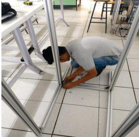
**Figura 7 Colocación de los elementos de fijación del perfil de aluminio.**
